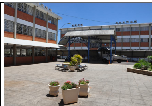
Figura 30 – Ar condicionado- vista externa
