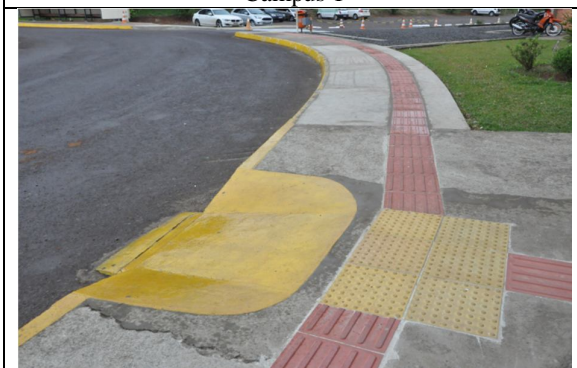
Figura 31 – Piso tátil - Câmpus II
