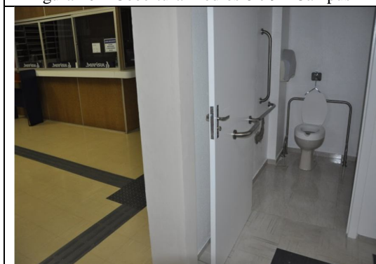
Figura 12 – Banheiro para portador de necessidades especiais - Câmpus 1
