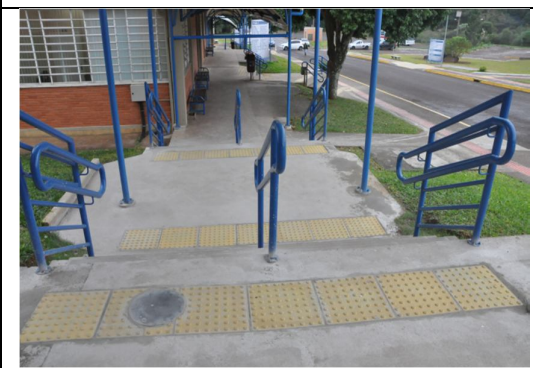
Figura 32 – Piso tátil - Câmpus II
