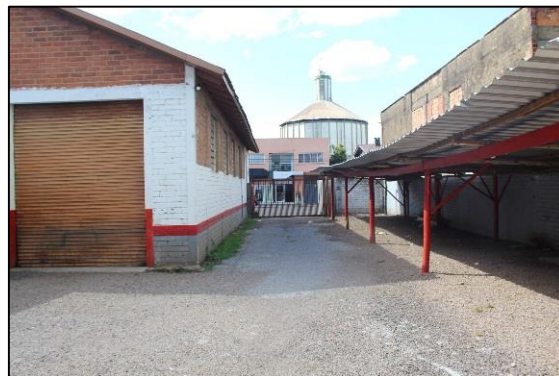
Figura 52 - Novo estacionamento para os funcionários e acadêmicos no Ambulatório do Hospital Santa Terezinha
