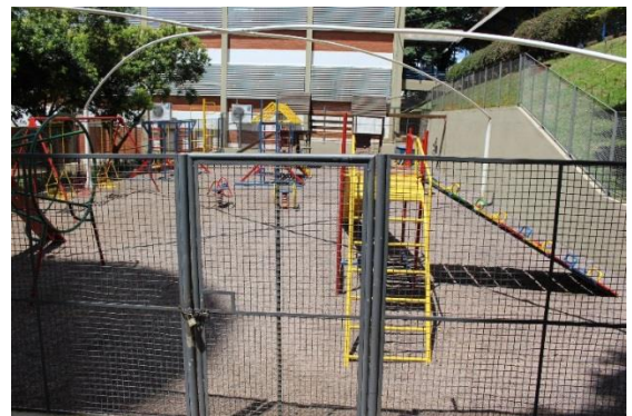
Figura 26 - Muro de contenção no Parquinho da escola
