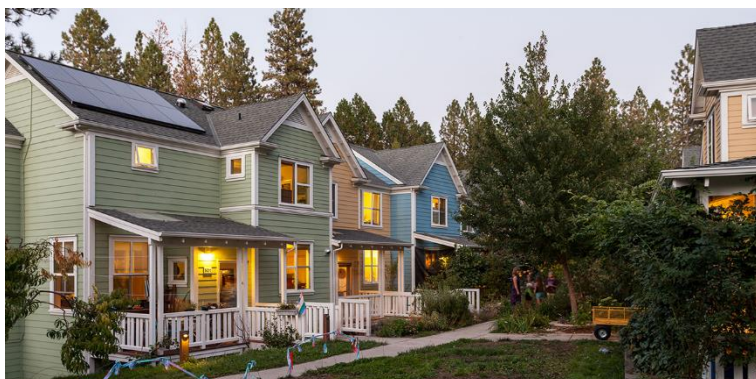
Figura 4 - Residências Nevada City Cohousing
