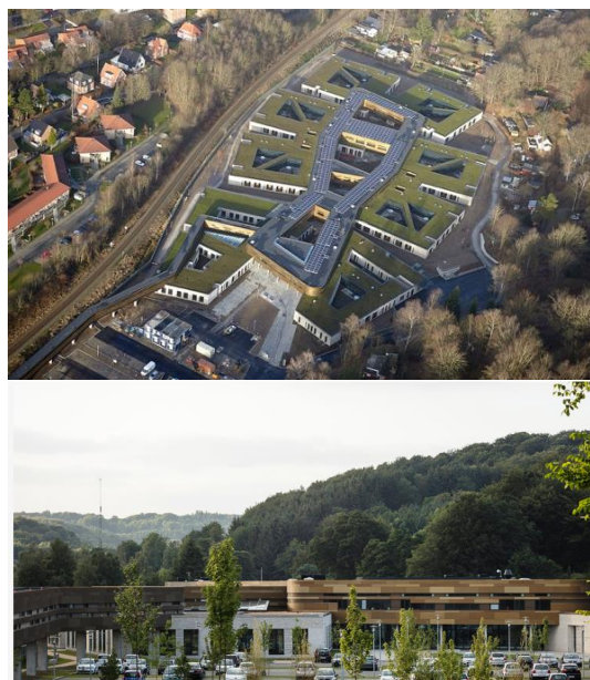
Figura 5 - Vista aérea e fachada com estacionamento
