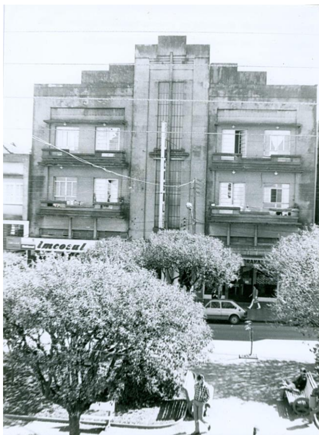
Figura 1 - Imagem do prédio dos Pagnoncelli
