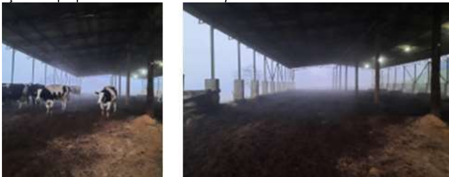
Figura 2. Instalações da propriedade no sistema Compost Barn
